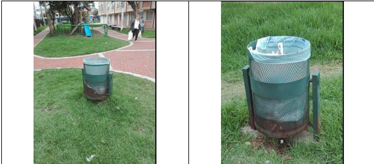
Foto 12 y 13. Ítem 15039-Suministro caneca M-120. Mala calidad de las cuatro canecas instaladas ya que como se observa presenta corrosión y oxido en la parte inferior.
